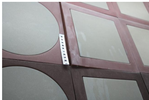
Figure 9 : Déformation et décollement des cartons du mur.
