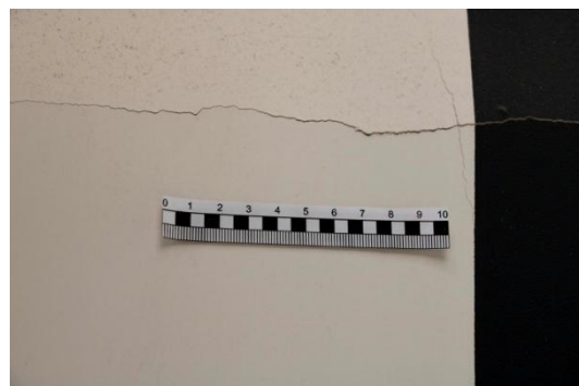
Figure 13 : Craquellement et soulèvement de la couche picturale du mur.
