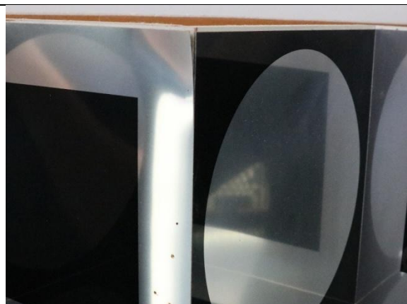
Figure 14 : TUKOER, Détail de soulèvement d'une plaque aluminium anodisé et taches brunâtres
