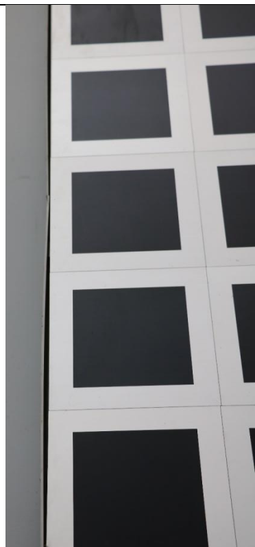
Figure 7 : SUPERNOVAE, Détail de la déformation de la bordure sur le côté gauche
