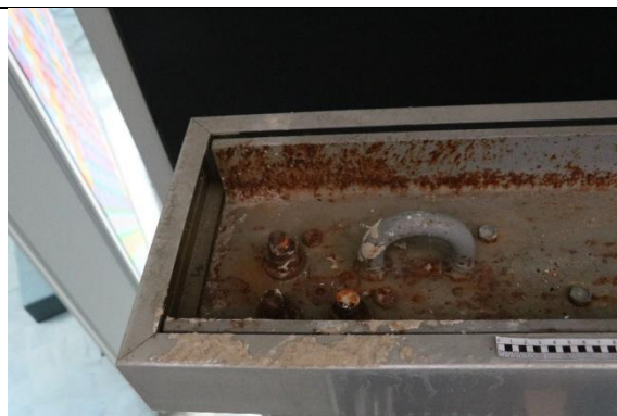
Figure 18 : CARACAS, Détail de la construction et corrosion en partie supérieure
