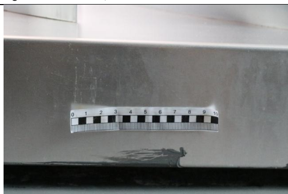
Figure 22 : CARACAS, Détail de projections de peinture et taches d'eau au bas du socle métallique
