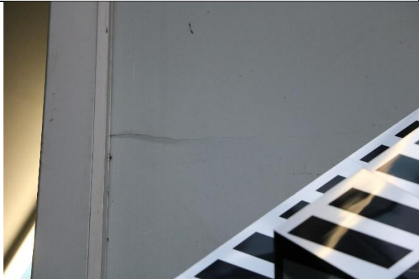
Figure 22 PYR-DAC, détail d'une fissure et soulèvement, en haut à gauche
